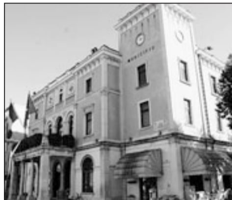
Il Municipio di Monfalcone, attualmente disabitato per lavori
