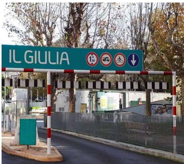
Foto 7: ingresso a raso marciapiede del parcheggio del Centro Commerciale
