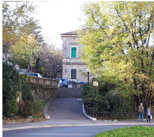
Foto 5: rampa sinistra della scalinata rotonda di via Pindemonte
