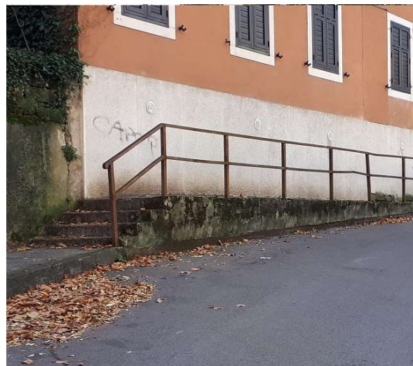
Foto 11: marciapiede e scalette di via Pindemonte ed edificio del centro diurno
