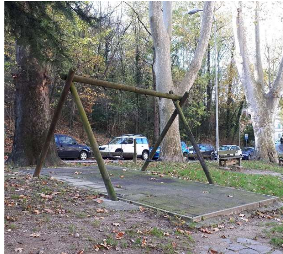
Foto 8: altalena lignea su pavimento antitrauma (un sedile risulta staccato)
