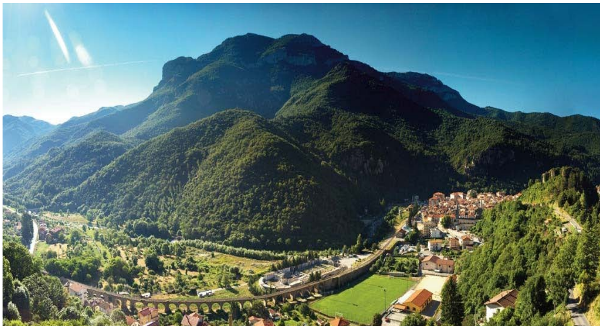
Il viadotto ferroviario della Ceva-Ormea in ingresso a Ormea
