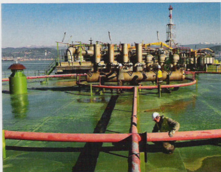
Tecnici sul tetto di un serbatoio controllano gli esplosivimetri, di cui a destra si vede un dettaglio. A sinistra: zona di trasformazione del gas, i quadri elettrici e, in basso, i serbatoi col gas liquido estratto dalla nave
